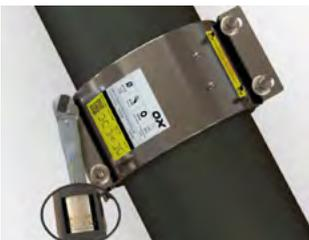
10. Serrez tous les écrous avec une clé dynamométrique uniformément et alternativement au couple préconisé (valeur indiquée sur l'étiquette).
